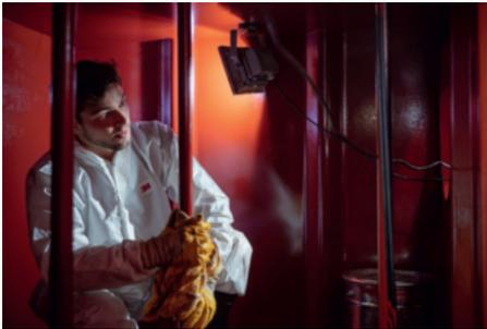
Unsere erfahrenen Tankrevisoren entfernen den Heizölschlamm sowie das Kondenswasser im Tank und reinigen ihn gründlich. Die Produkte- und Entlüftungsleitungen werden demontiert und es folgt eine Meldung an die zuständige Amtsstelle. Das restliche Heizöl\* entsorgen wir fachgerecht oder transportieren es in eine andere Liegenschaft. Unsere Fachleute beraten Sie gerne persönlich und erstellen ein Angebot für Sie.
