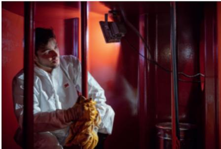
Nos réviseurs de citerne expérimentés enlèvent les boues de mazout et l'eau de condensation de la citerne et nettoient à fond la citerne. Les conduites de remplissage et d'aération sont démontées et l'office compétent est notifié. Nous évacuons le mazout\* restant dans les règles de l'art ou le transférons vers une autre propriété. Nos spécialistes vous conseillent volontiers personnellement et vous établissent une offre.
