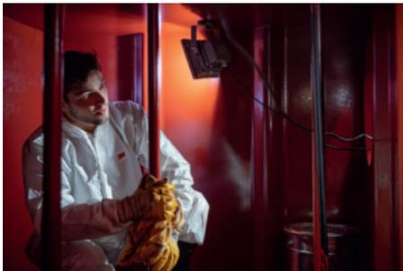
I nostri esperti tecnici di revisione rimuovono la melma oleosa e l'acqua di condensazione presenti nella cisterna e la puliscono accuratamente. Le condotte di alimentazione e di sfiato vengono smontate e viene informato l'ufficio responsabile. Smaltiamo correttamente l'olio combustibile residuo\* o lo trasportiamo in un altro immobile. I nostri specialisti saranno lieti di consigliarla di persona e di preparare un'offerta per lei.
